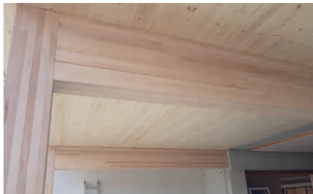
Stützen und Träger aus Fagus-Stabbuche im neuen Schulhaus-Anbau in Lausen BL
