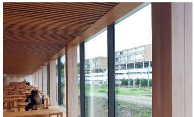
Hochleistungs-Stützen aus Fagus-Stabbuche im UVEK Campus, einem neuen Verwaltungsgebäude des Bundes in Ittigen BE
