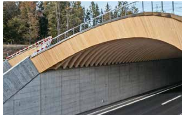
Noch sind die Abschlussarbeiten im vollem Gange. Dann wird die erdüberdeckte Brücke in ihrer gesamten Breite bepflanzt.
