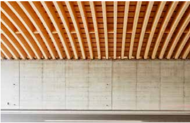
Sie geben dem Tragwerk der Doppelbrücke ihre Form: 156 Bogenbinder aus Brettschichtholz. Stahlteile, sogenannte Metallschuhe, an beiden Seiten der Träger sorgen für die nötigen Auflager zur Montage.
