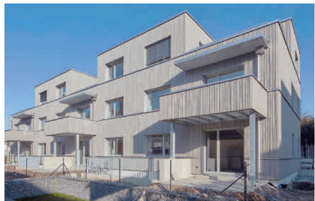
Brettsperrholz-Mehrfamilienhaus in Bern-Bümpliz (Architekten: Büro 21 Architektur, Bern; Holzbauingenieure: Timbatec Holzbauingenieure Schweiz AG, Bern). BILD NILS SANDMEIER
