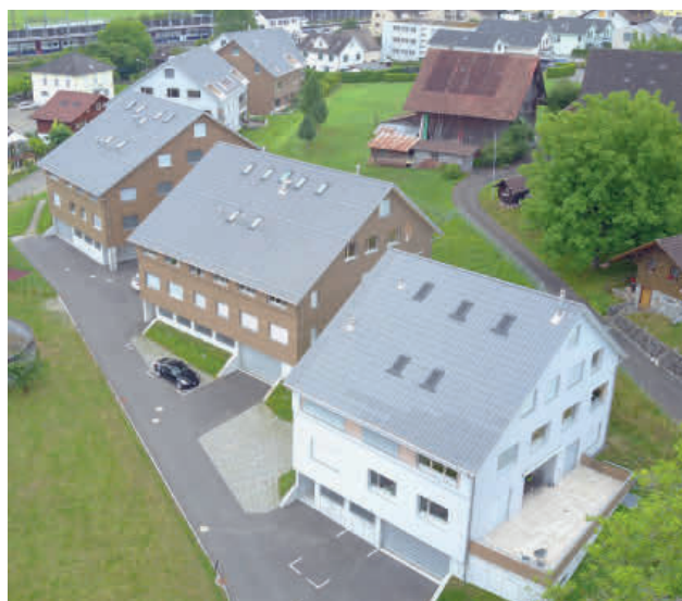
Sechs fünfgeschossige Minergie-Eco-Mehrfamilienhäuser aus Brettsperrholz in Knonau. BILD BAUREALIT GMBH
