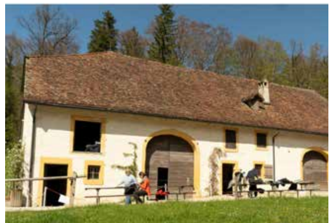
Mehrzweckgebäude Lancy, Ballenberg
