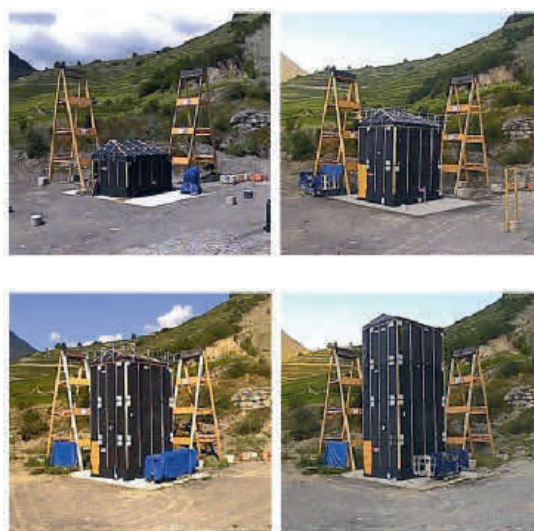
Abb. 1: Gebäude G1, G2, G3 und G4.
