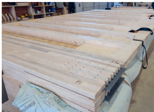
Figure 2 - Assemblage broché réel
