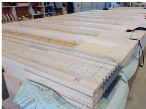
Figure 2 - Assemblage broché réel
