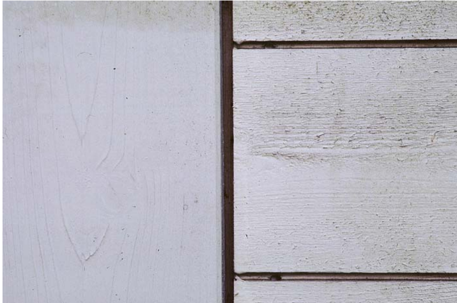
Abbildung 6: Sägerauhe Schalung (rechts) mit deckend weiss pigmentierte 'Lasur', sehr gute Dauerhaftigkeit (nach bislang 14 Jahren immer noch weitgehend intakt) und: Die Holzstruktur ist noch erkennbar.
