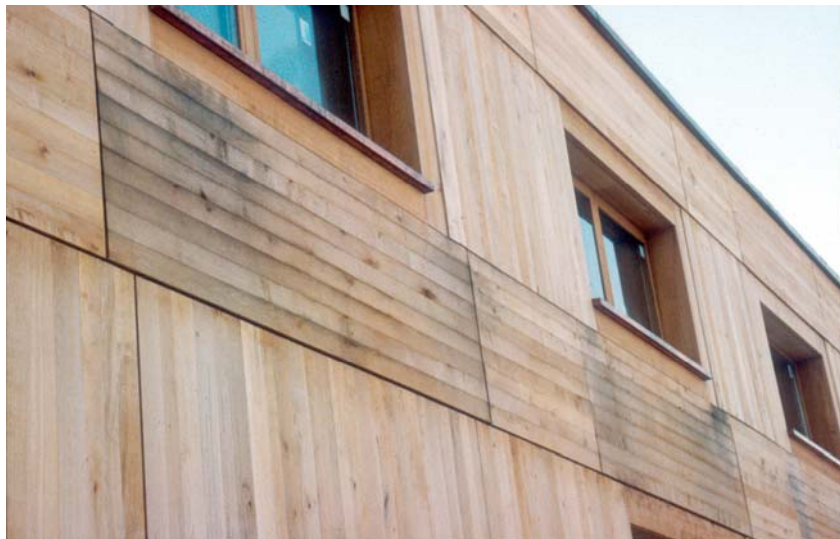
Abbildung 2: Ungeschützt wetterexponierte Fassade aus Eichenholz. Das Kernholz von Eiche und auch von Kastanie ist zwar dauerhaft gegen biologischen Abbau, das Verwitterungsverhalten ist aber nicht unproblematisch: starke, oft ungleichmässige Verfärbungen, Auslaugung von Gerbstoffen, die andere Bauteile darunter verfärben, schwierige Oberflächenbehandlung. Auch Eichenholzfassaden sollen daher durch Vordächer und Fassadenvorsprünge wettergeschützt werden.
