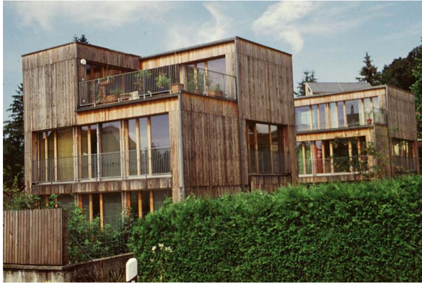
Abbildung 1: Stark wetterexponierte Fassaden ohne Vordach verhalten sich im Unterhalt anders als wettergeschützte. In solch einem Fall sollten im übrigen metallverkleidete Holzfenster eingesetzt werden, weil reine Holzfenster (entgegen verbreiteter Meinung auch solche aus Lärchenholz) durch die starke Wetterexposition überfordert werden.
