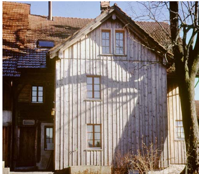
Abbildung 7: Einheitlich und attraktiv vergraute Westfassade eines Bauernhausanbaus im Zürcher Oberland.
